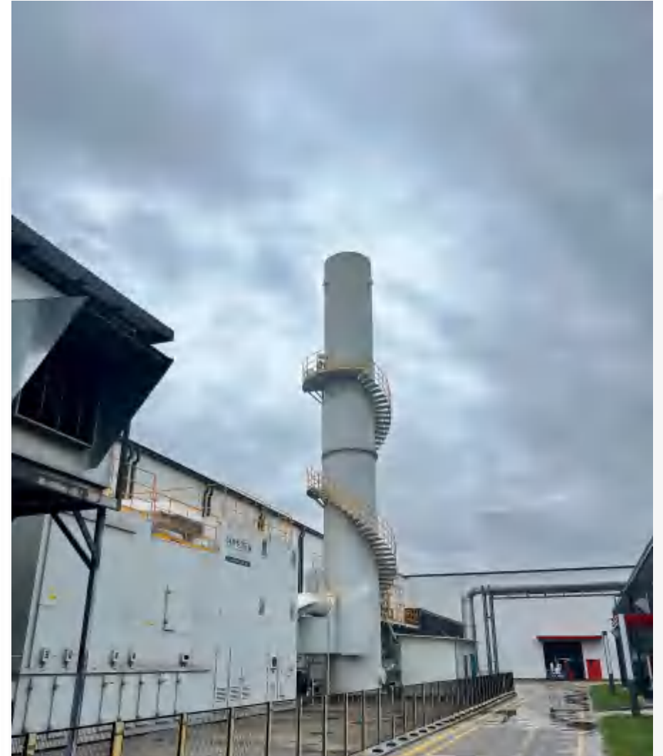
华世洁沸石转轮和VOCs 废气处理设备
