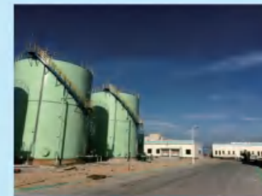
广西防城港 LNG Guangxi Fangchenggang LNG
