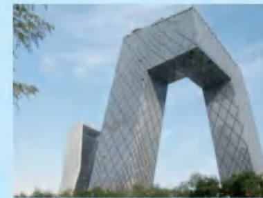
CCTV新台 New CCTV Building
